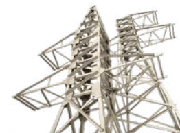
Опоры ЛЭП и ВЛ
